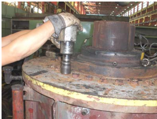
Slika 4. Pneumatsko odvijanje vijčanih veza
