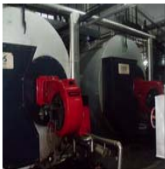
Slika 3.a) Kotlovi instalirani u Pivari Tuzla
