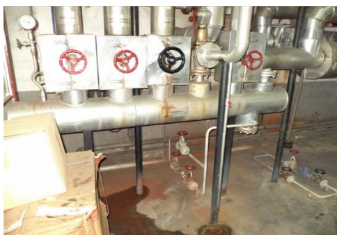
Slika 6. Pravilna izvedba odvajača kondenzata na razdjelniku pare 4 bara u kotlani
