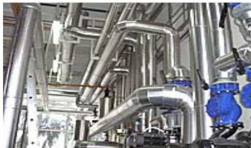
Slika 1. Izolacija cjevovoda u jednom industrijskom postrojenju
