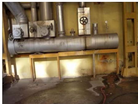
Slika 7. Nepravilna izvedba odvajača kondenzata na razdjelniku pare ispred kuhaone
