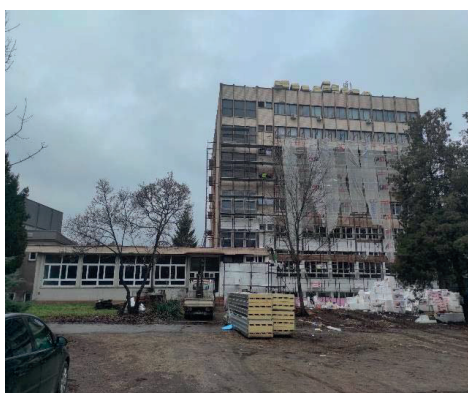
Slika 9..Objekat MTF-a za vrijeme radova
