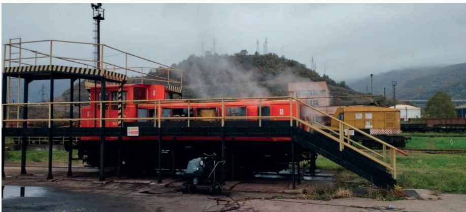
Slika 3. Platforma za pranje lokomotiva [8]
