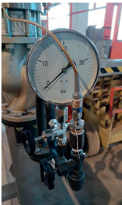
Slika 2. Lokacija senzora pritiska (uz postojeći manometar na sistemu)
