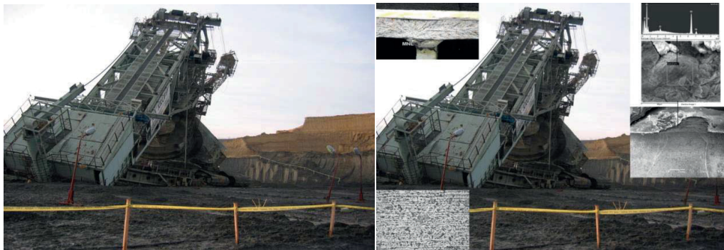
a) b) Slika 4.1. Pad strijele i protutega nakon pucanja uški na strelji a) opći izgled havarije b) detalji analize loma
