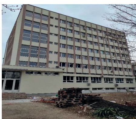
Slika 10. Izgled MZF-a nakon radova
