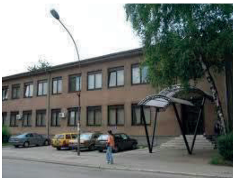
Slika 5. Zgrada Rektorata prije radova
