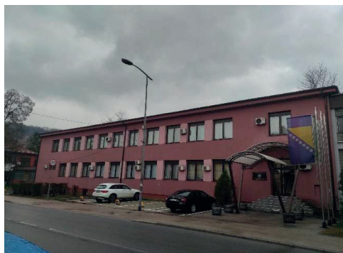
Slika 6. Zgrada Rektorata nakon radova
