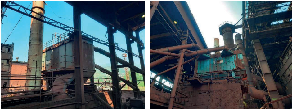
Slika 1. Vrećasto filtersko postrojenje u kompaniji za proizvodnju čelika
